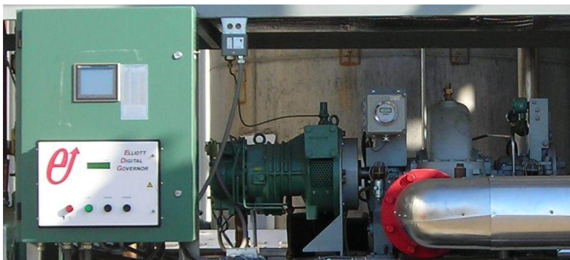
Figure 44: Turbina cu Abur acționează un Răcitor
